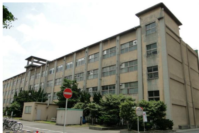
南東から見た建物風景
