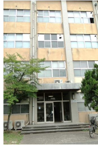
旧経営工学科入口
